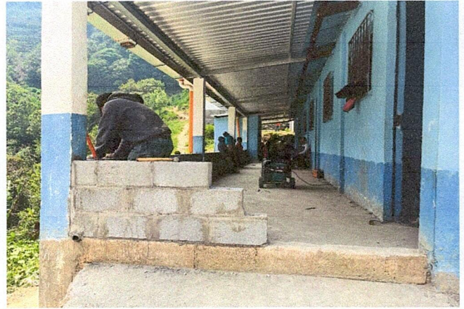
CERCO O MURO PERIMETRAL
